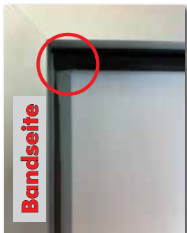
Ansicht Zarge von vorne, Bandseite rechts
